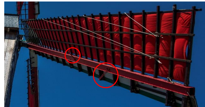
Verhaegheroede: zeilklampen van geplooid rondijzer!!!
