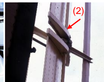
Holle rib met klepas Foto Toon Van As
