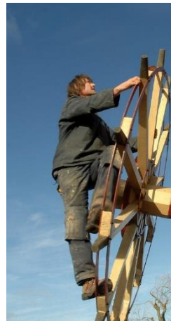
'Kruirad' + 8 spaken. Hierin kan ook gelopen worden. De munnik verschuift in de staart door de kruiketting foto Toon Van As
