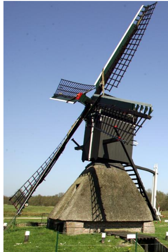
Omwille van de hoeken van de ruime ondertoren ligt de as (wieken) onder een grotere hoek
