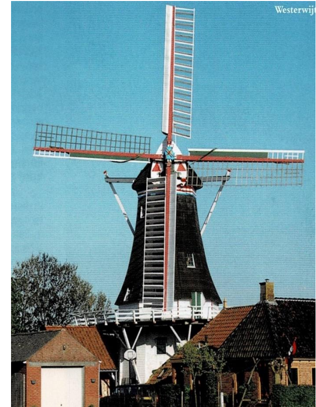
Zelfzwichting met Van Busselneuzen op de binnenroede en Oud Hollands op de buitenroede
