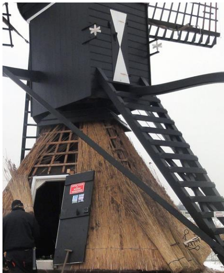
De onderzetel rust op de ondertoren
