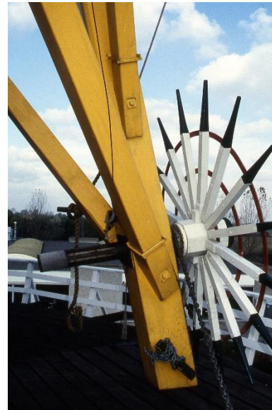
'Kruirad' + 8 spaken. Hierin kan ook gelopen worden. De munnik verschuift in de staart door de kruiketting foto Toon Van As
