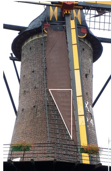
Lange halve onderste zwichtlijn los
