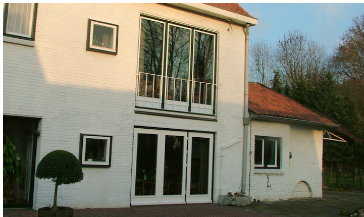
Verbouwing door Widdershoven, met rechts het waterrad-huis
